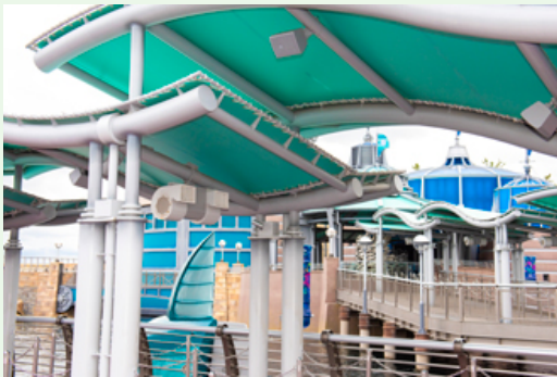
屋根と送風機を設置した「ニモ&フレンズ・シーライダー」の屋外待ち列エリア
