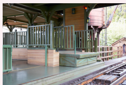
プラットフォームの床をかさ上げすることで、車イスのまま利用できるように
