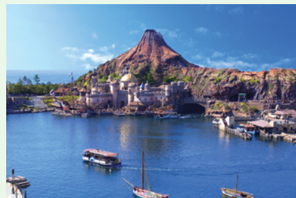
水を効率的に循環させている 東京ディズニーシーの水域
