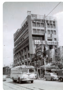
設立当時の本社があったビル
