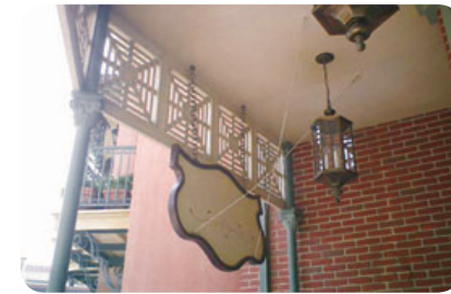
吊りものの補強
