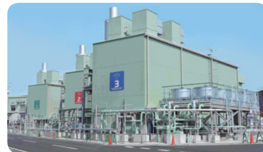
最大15,000キロワットを発電する自家発電設備
