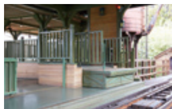
プラットホームの床をかさ上げすることで、車イスのまま利用いただけるように
