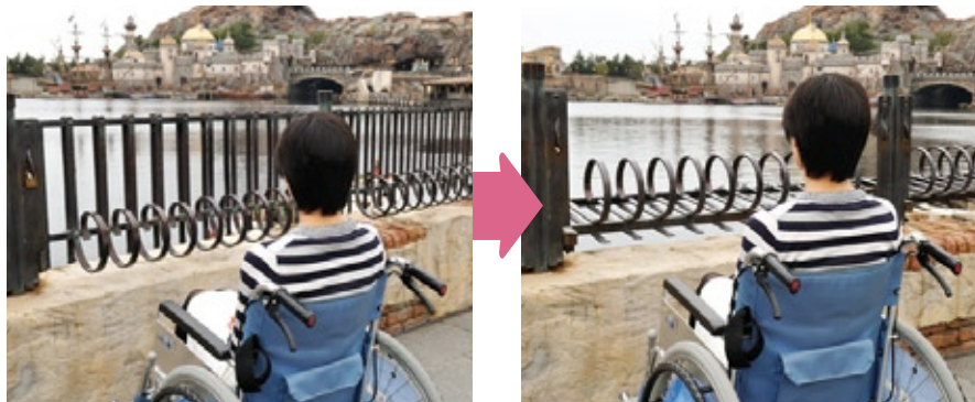
車イスゲスト対応の可動式安全柵
