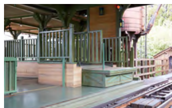
プラットホームの床をかさ上げすることで、車イスのまま乗車できるように
